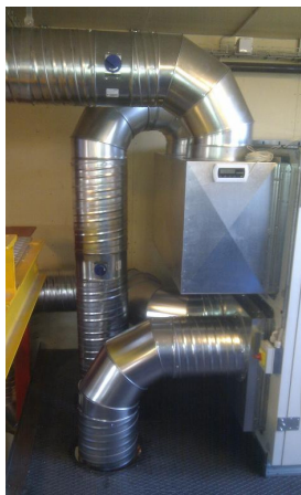
Punktudsugning ved støbemaskine - sugehoved på magnet.
