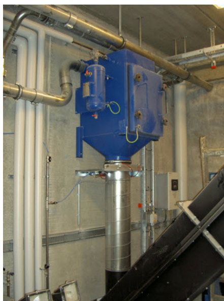
Filteranlæg udført i kraftig lakeret stålplade. Filterrensning via trykluftimpulser.
