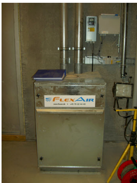
Vakuumpumpe indbygget i støjdæmpende kabinet med aftagelig frontlåde.
