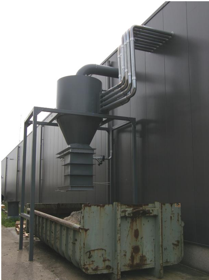
Cyklonudskilleren er monteret på kraftigt benstativ. Enheden er samlet og monteret på stedet.
