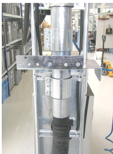
Sugeudtag i produktion - med slange frem til afsugning i de enkelte maskiner
