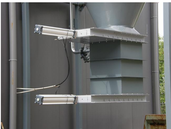
Udladning af materiale sker trykløst gennem spjæld, for at sikre at der er konstant vakuum på systemet til kontinuerlig drift og udsugning af spåner.
