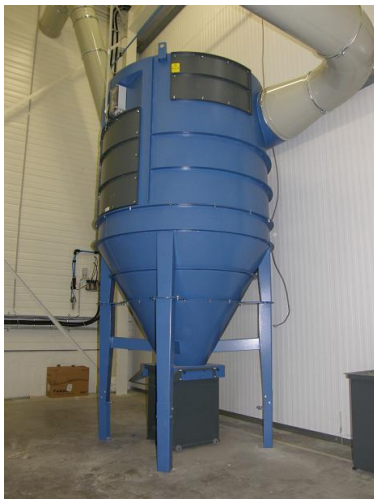
Komplet filteranlæg med automatisk filterrensning. Opsamling af det fine støv sker i stor spand på 120 ltr. under filteranlæg. Anlægget har et filterareal på i alt 130 m 2 .
