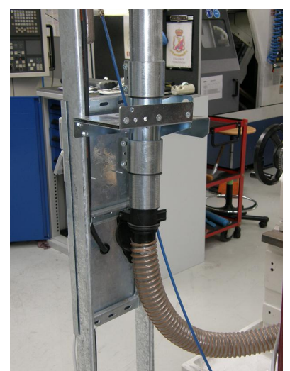
Sugeudtag i produktion - med slange frem til afsugning i de enkelte maskiner
